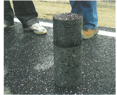
Bild 8: Bohrkern aus dem 1. Bauabschnitt
