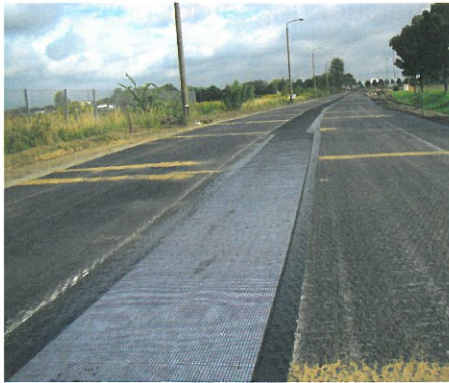
Bild 6: Fahrbahnoberfläche im 1. Bauabschnitt nach dem Fräsen, Gitter im Bereich der Mittelnaht
