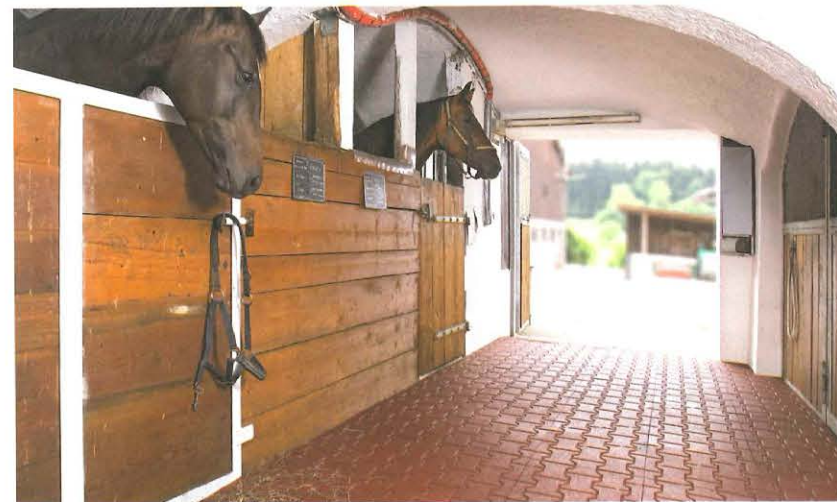
Ein Beispiel für die stoffliche Verwertung: Stallboden aus Altreifen-Granulat, Quelle: KRAIBURG Relastec
