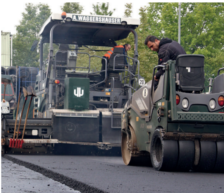
Gummi findet Verwendung in speziellen schallschluckenden Asphaltmischungen.
