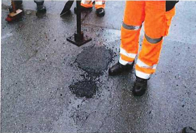
Abb. 4.1: nach dem Einbau
