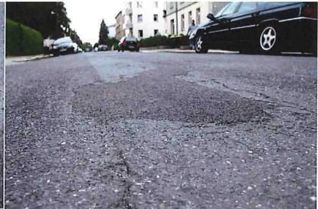
Abb. 4.10: während der zweiten Kontrolle
