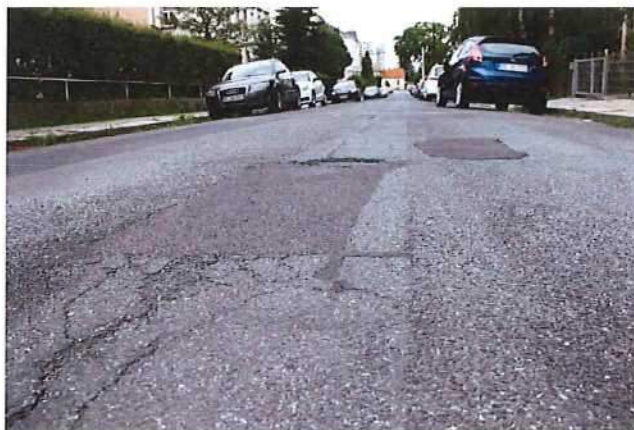
Abb. 4.23: während der zweiten Kontrolle
