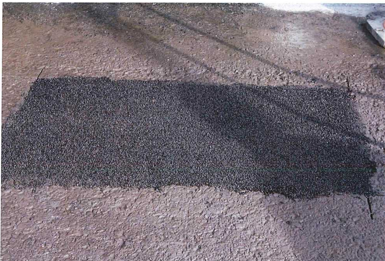
Abb. 3.19: Versuchsstelle 12: Nach der Verdichtung
