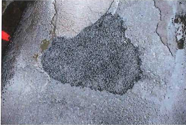
Abb. 4.40: nach dem Einbau
