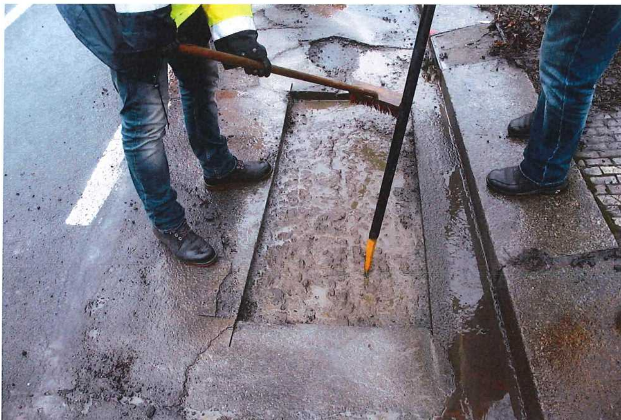
Abb. 2.16: Versuchsstelle 8 : Vor der Verfüllung mit Kaugummi-asphalt®
