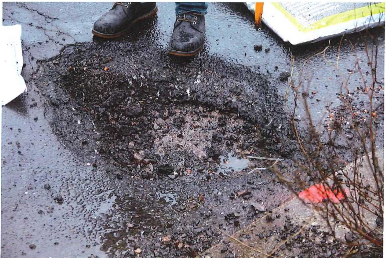
Abb. 2.4: Versuchsstelle 6: Nach dem Vorbereiten
