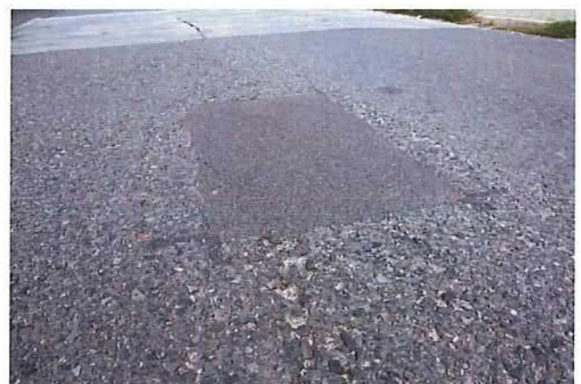
Abb. 4.83: während der zweiten Kontrolle
