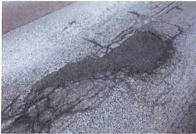
Abb. 4.9: während der zweiten Kontrolle
