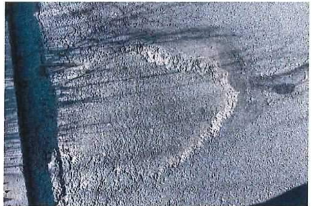
Abb. 4.35: während der ersten Kontrolle
