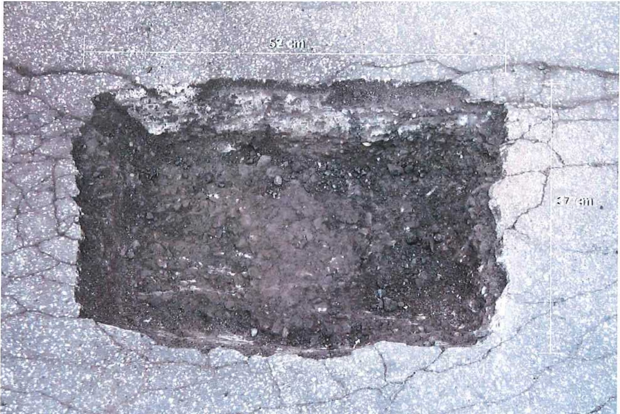
Abb. 3.10: Versuchsstelle 11: Vor dem Einbau mit einer Tiefe von 11 cm
