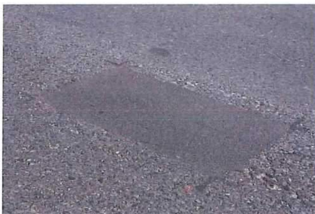
Abb. 4.82: während der zweiten Kontrolle
