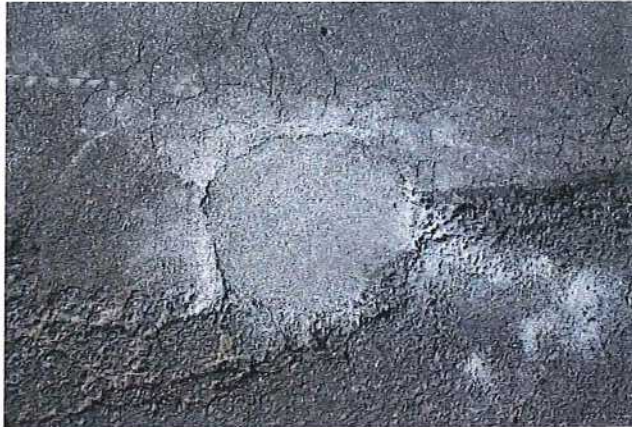
Abb. 4.65: nach dem Einbau
