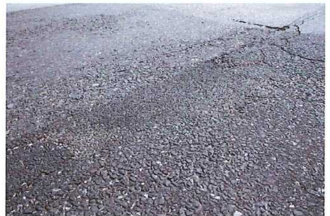
Abb. 4.60: während der zweiten Kontrolle
