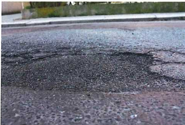
Abb. 4.15: während der zweiten Kontrolle
