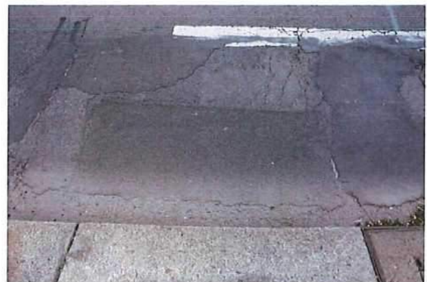
Abb. 4.49: während der zweiten Kontrolle
