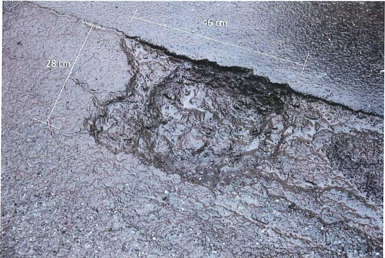
Abb.1.7: Versuchsstelle 3: Tiefe des Schlagloches 4,5 cm
