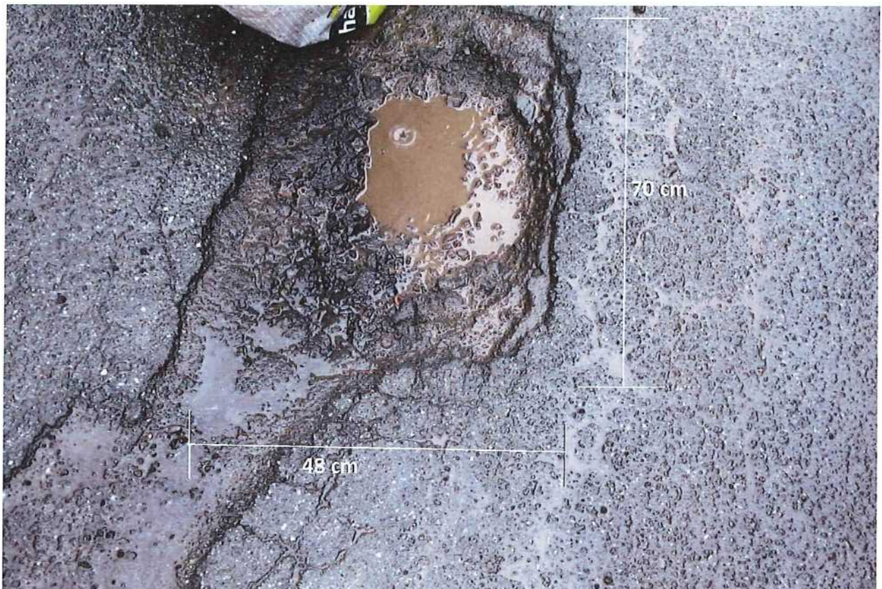
Abb.1.4: Versuchsstelle 2: Unter Beobachtung nur der vermaßte Bereich des Schlagloches; Lochtiefe von 6,5 cm (Mitte) und 1 cm (Rand)
