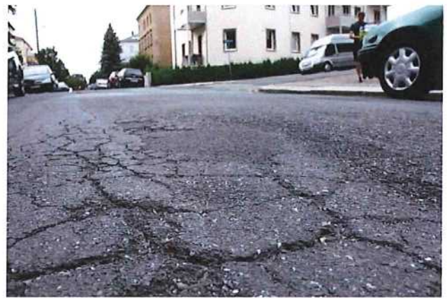
Abb. 4.4: während der zweiten Kontrolle
