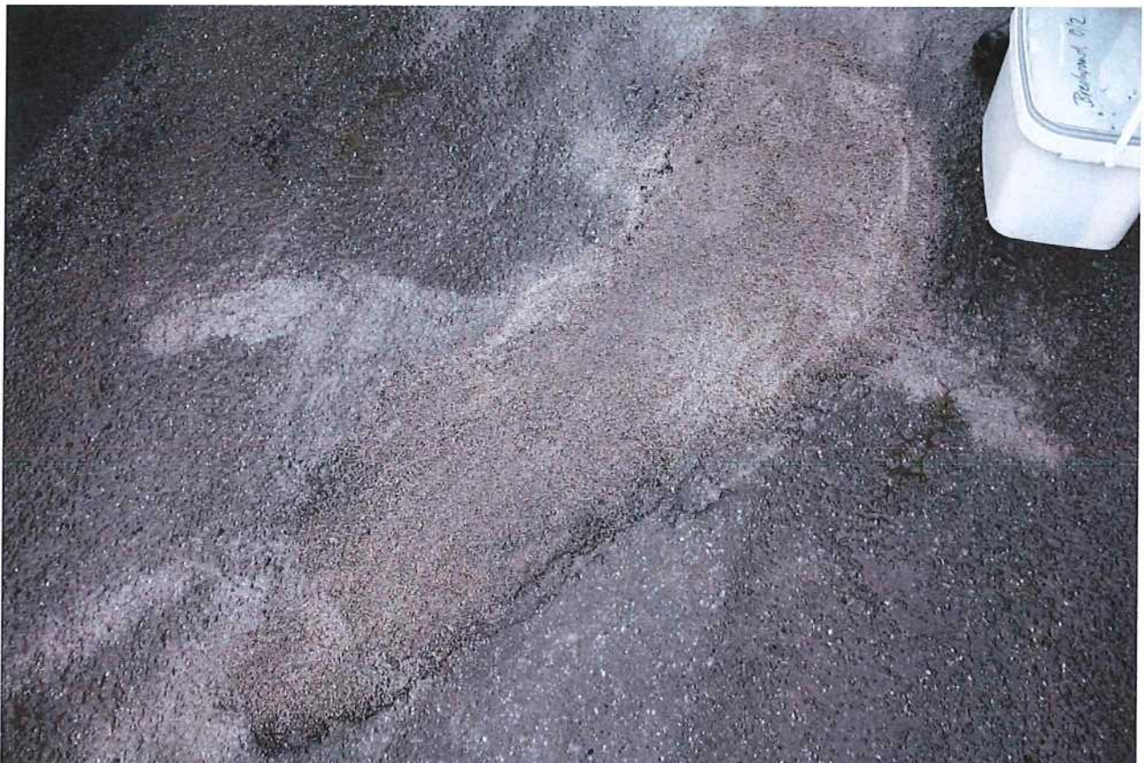
Abb.1.6: Versuchsstelle 2: Abstreuerung mit gebrochener feiner Gesteinskörnung 0/2
