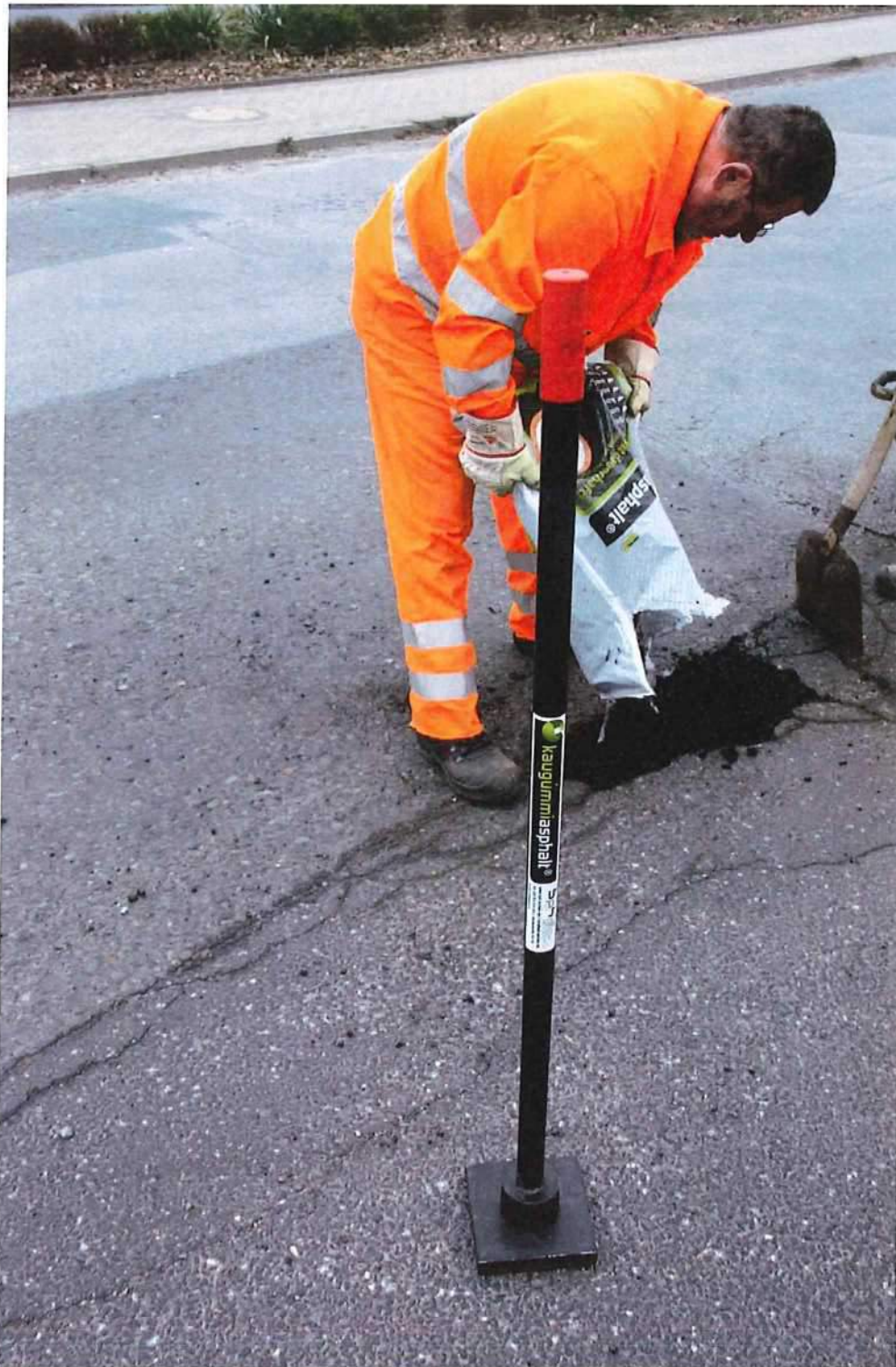
Abb. 3.3: Versuchsstelle 9: Während des Verfüllens mit dem Handstampfer
