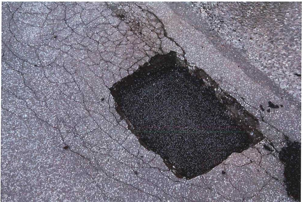
Abb. 3.11: Versuchsstelle 11: nach dem Einbau der 1. Lage Kaugummi-asphalt®
