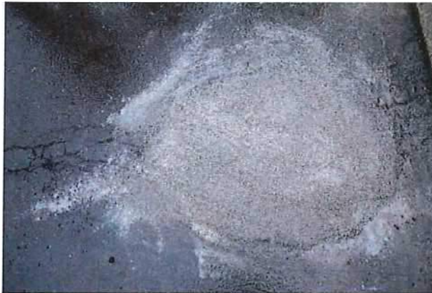
Abb. 4.34: nach dem Einbau
