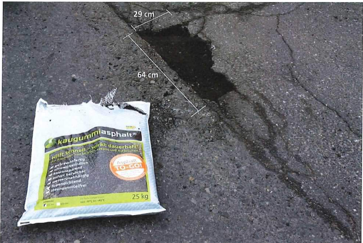
Abb. 3.2: Versuchsstelle 9: Mit einer Schlaglochtiefe von 5 cm
