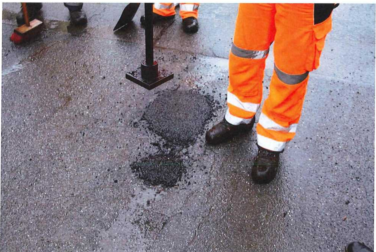
Abb.1.2: Versuchsstelle 1: Verdichtung mit Handstampfer
