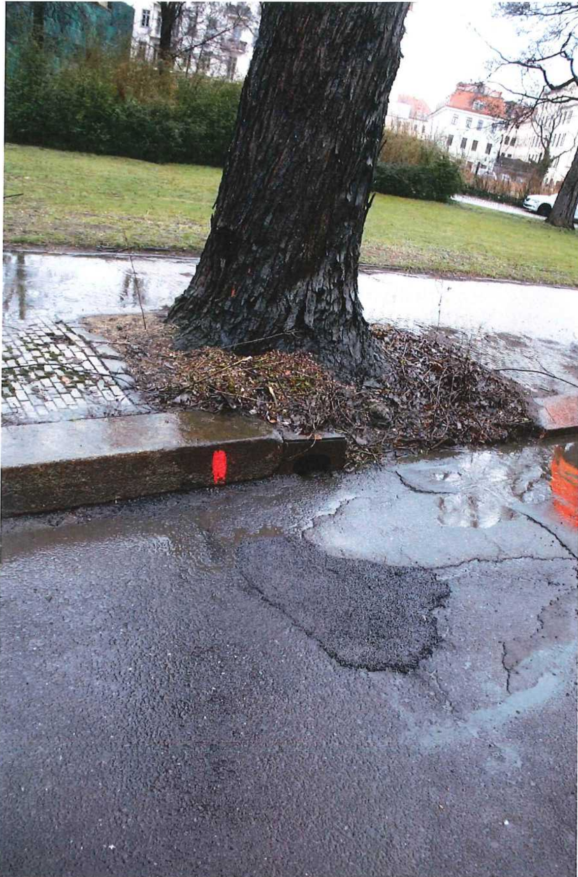
Abb. 2.10: Versuchsstelle 7 : Nach dem Verdichten mit Blick zur Straßenentwässerung
