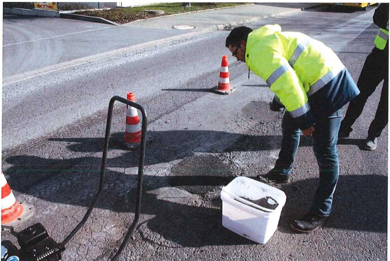
Abb. 3.7: Versuchsstelle 10: Vor dem Abstreuen mit Brechsand
