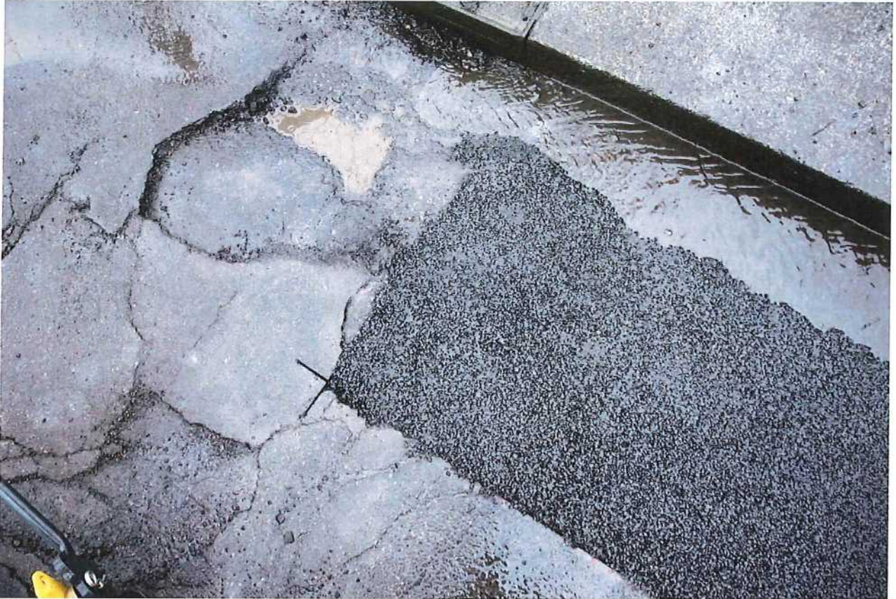
Abb. 2.17: Versuchsstelle 8: Nach der Verdichtung (Wasser strömt über Versuchsstelle)
