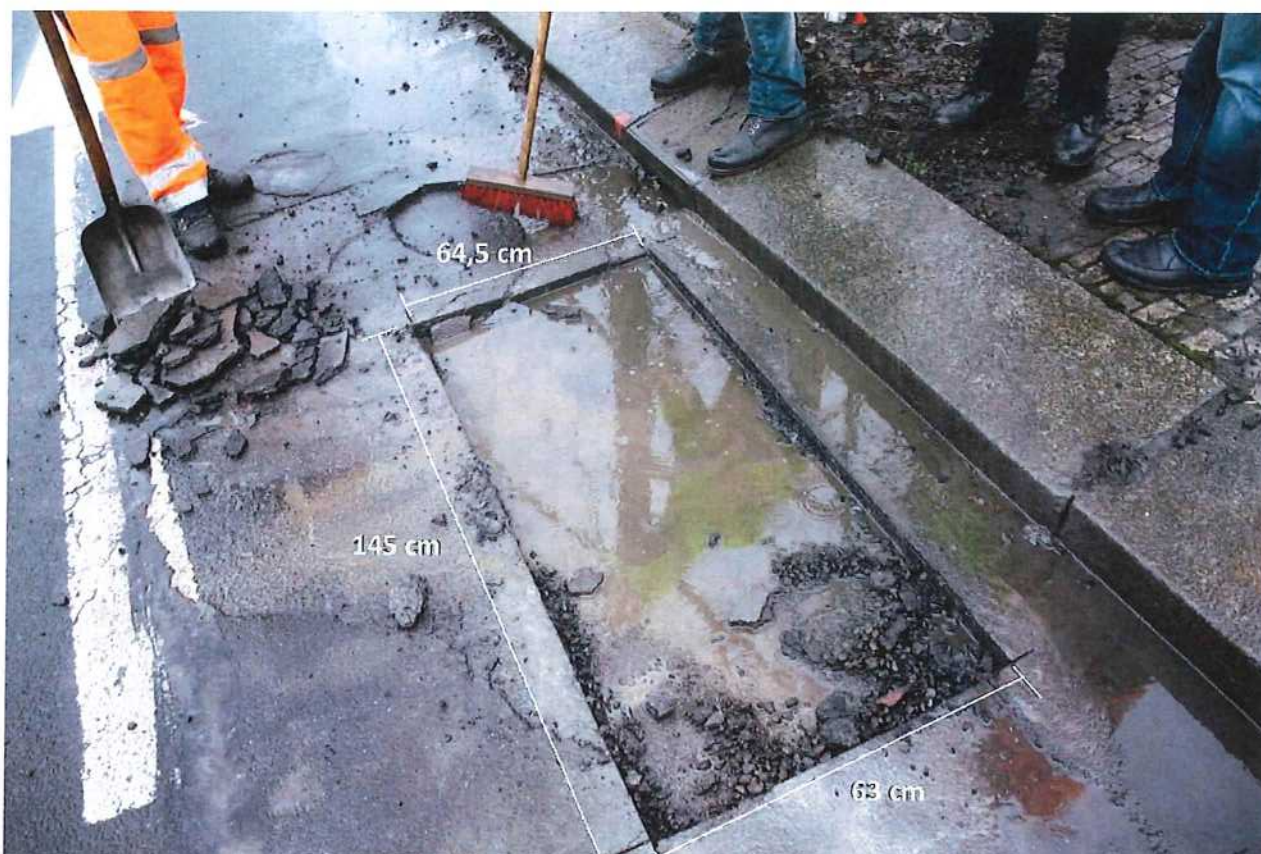
Abb. 2.15: Versuchsstelle 8 : Mit einer Tiefe von 5,5 – 7,5 cm, vor dem Aufbereiten
