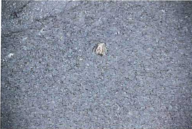
Abb. 4.50: während der zweiten Kontrolle
