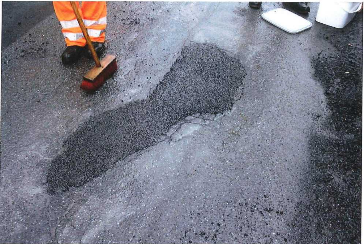
Abb.1.5: Versuchsstelle 2: Verfüllung und Verdichtung abgeschlossen
