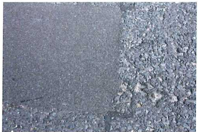
Abb. 4.85: während der zweiten Kontrolle
