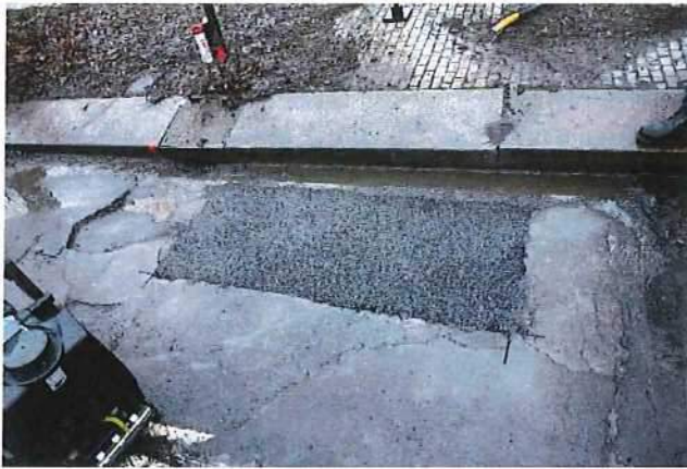
Abb. 4.46: nach dem Einbau
