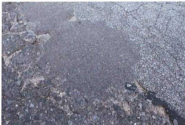
Abb. 4.67: während der zweiten Kontrolle
