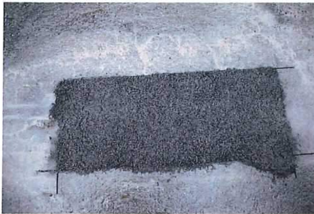
Abb. 4.19: nach dem Einbau
