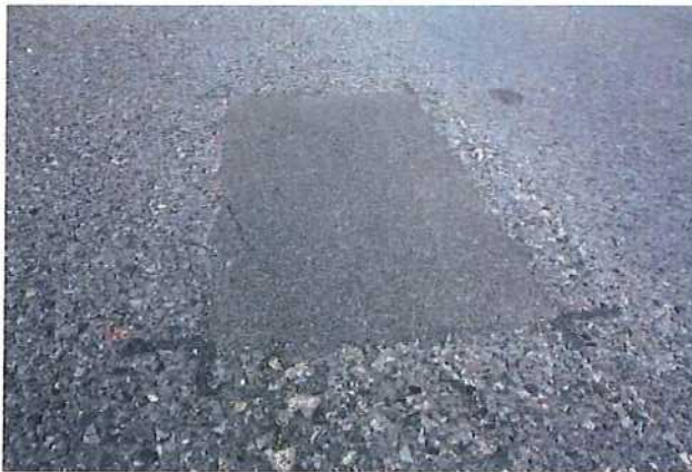
Abb. 4.84: während der zweiten Kontrolle
