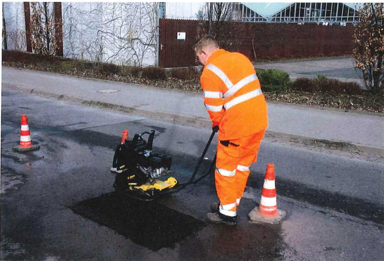
Abb. 3.18: Versuchsstelle 12: Während des Verdichtens der 2. Lage
