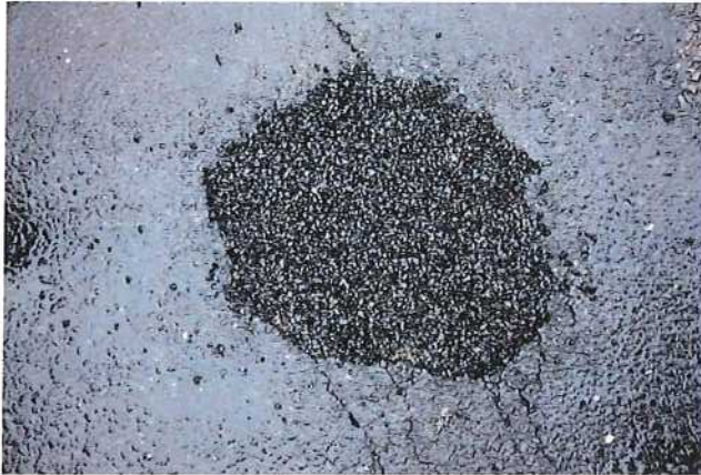
Abb. 4.28: nach dem Einbau
