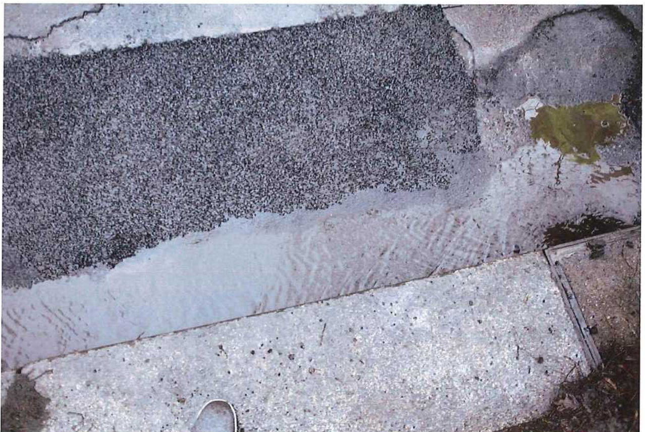
Abb. 2.18: Versuchsstelle 8: Nach der Verdichtung
