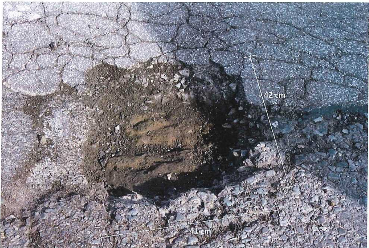
Abb. 3.6: Versuchsstelle 10: mit einer Schlaglochtefe von 5 – 7 cm
