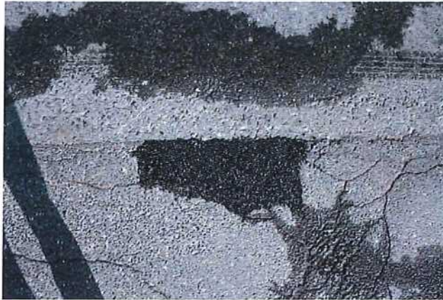
Abb. 4.56: nach dem Einbau
