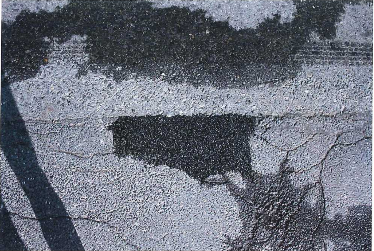
Abb. 3.4: Versuchsstelle 9: Nach dem Verdichten
