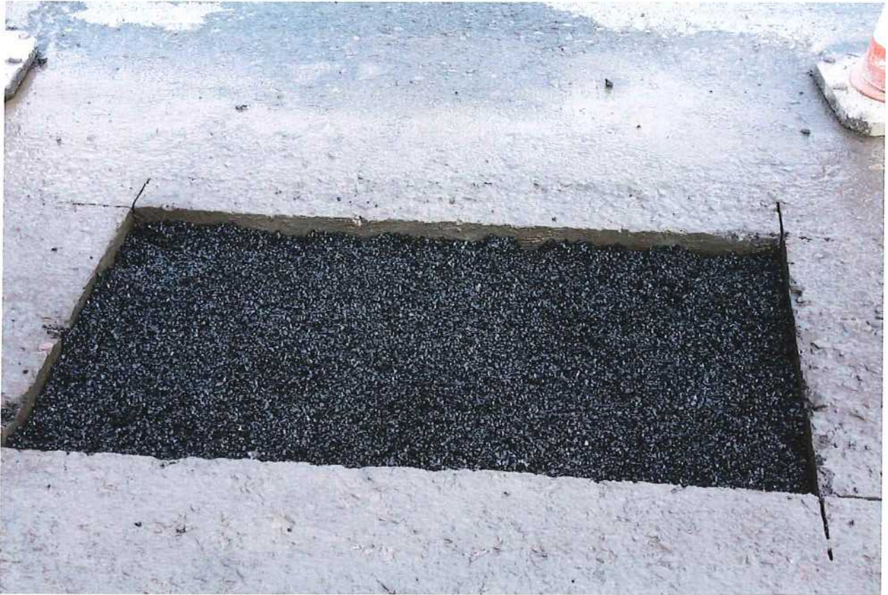
Abb. 3.16: Versuchsstelle 12: Nach dem Einbau der 1.Lage
