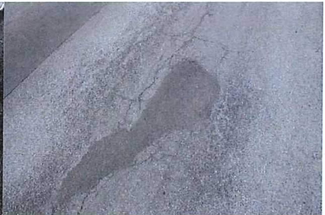
Abb. 4.8: während der ersten Kontrolle
