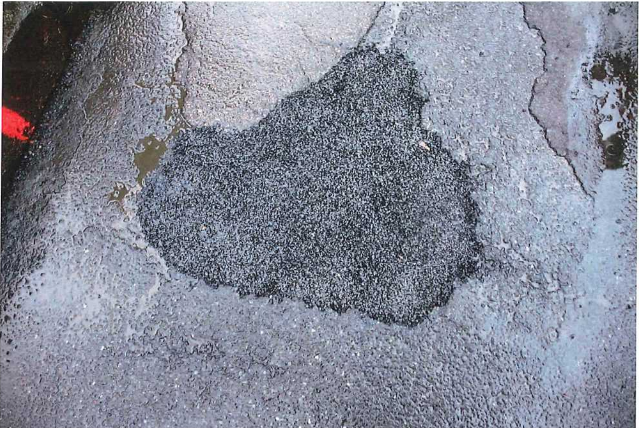
Abb. 2.11: Versuchsstelle 7: Nach dem Verdichten
