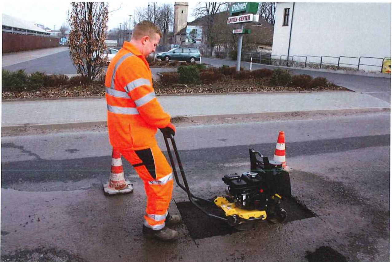
Abb. 3.17: Versuchsstelle 12: Während des Verdichtens der 1. Lage mit der Rüttelplatte
