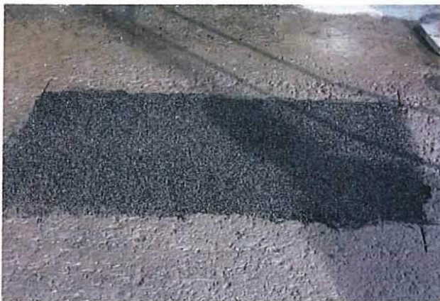
Abb. 4.79: nach dem Einbau
