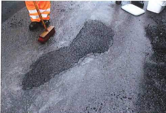
Abb. 4.7: nach dem Einbau
