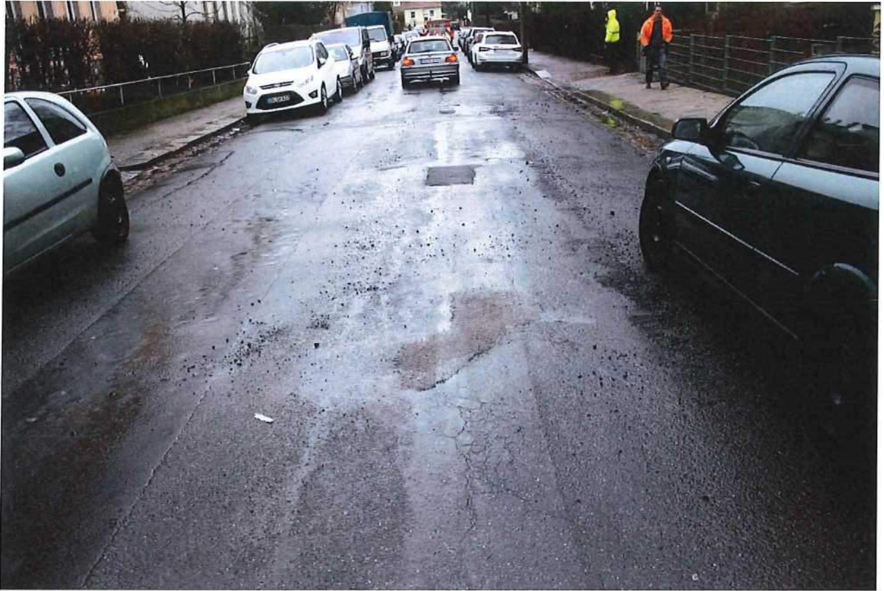
Abb.1.13: Gesamtübersicht der Versuchsstellen 2, 3 und 4
