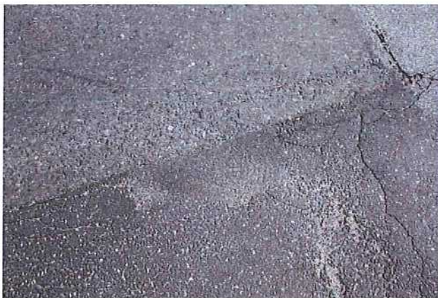
Abb. 4.59: während der zweiten Kontrolle
