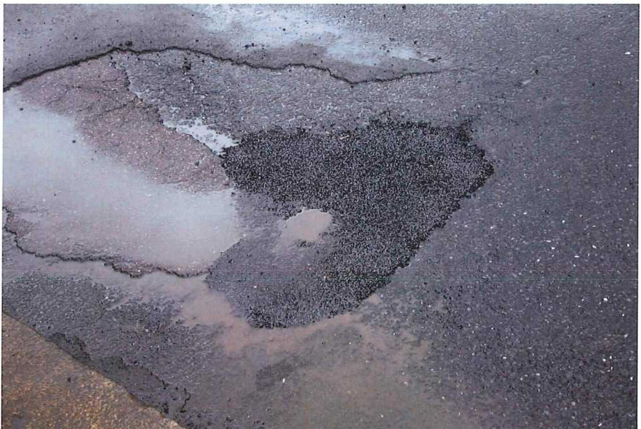
Abb. 2.12: Versuchsstelle 7: Nach etwa einer Stunde (Wasser steht in einem kleinen Loch)
