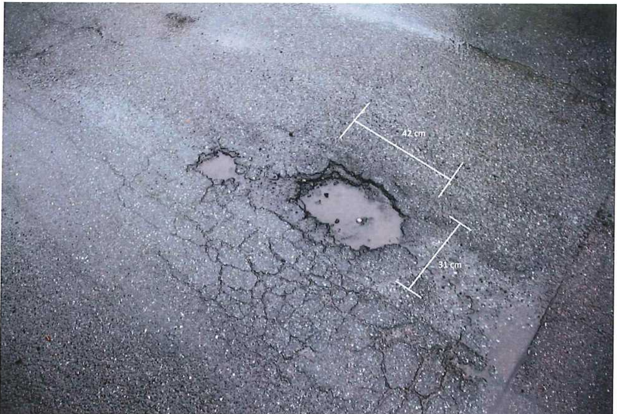
Abb.1.1: Versuchsstelle 1: Schlagloch mit einer Lochtiefe von 2-4 cm
