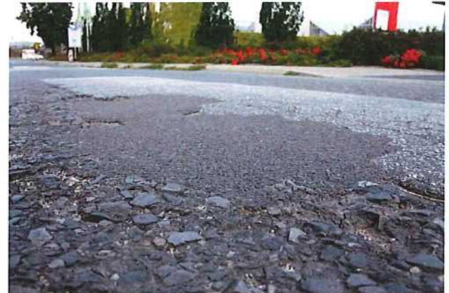
Abb. 4.68: während der zweiten Kontrolle
