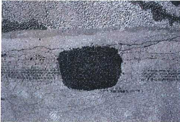
Abb. 4.71: nach dem Einbau
