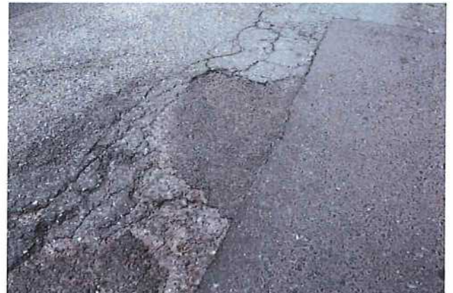
Abb. 4.16: während der zweiten Kontrolle
