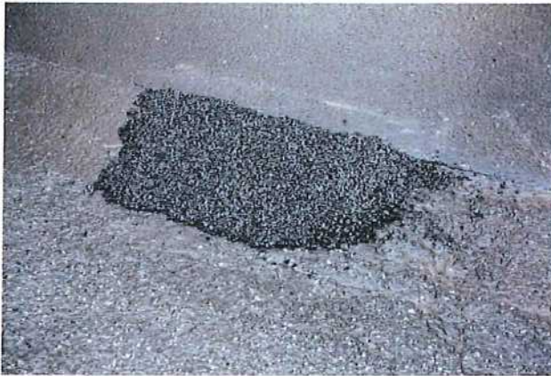
Abb. 4.13: nach dem Einbau
