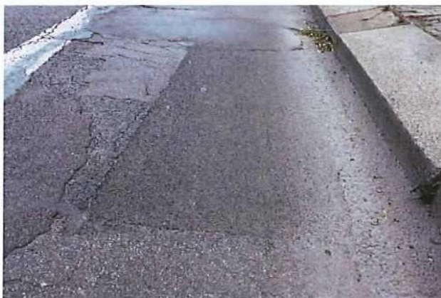
Abb. 4.48: während der zweiten Kontrolle
