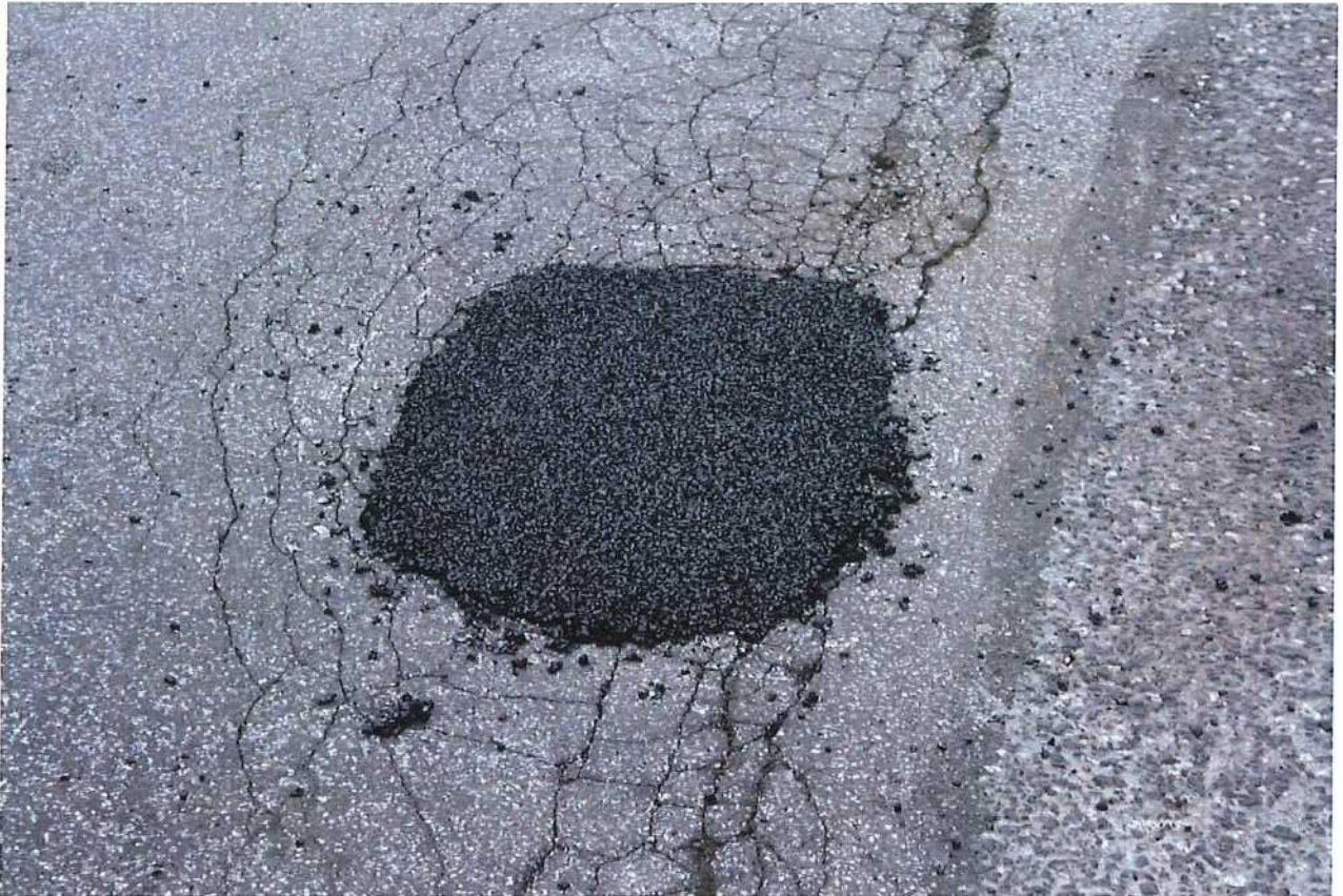
Abb. 3.12: Versuchsstelle 11: Nach dem Einbau der 2. Lage Kaugummiasphalt®
