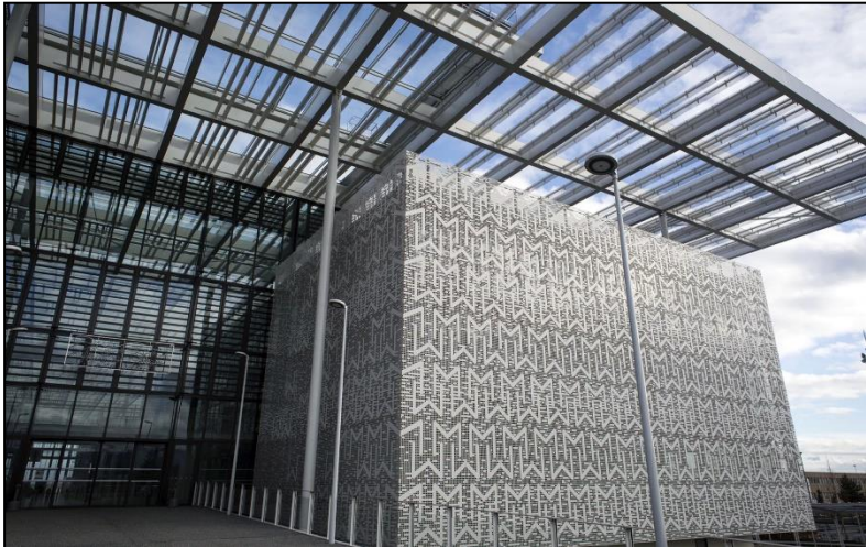
Bild 3: Der MICHELIN RDI-Campus (Research, Development, Innovation) in Ladoux (Frankreich) ist das "Herzstück" der Forschung und Entwicklung von Reifen des internationalen Konzerns. Bildquelle: Michelin.
